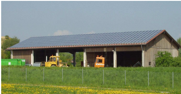
Photovoltaikanlage auf dem Dach des Wertstoffhofes und der Umladestation Breitenbrunn Foto: LRA
