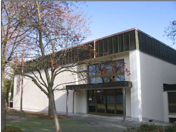
Sanierung Sporthalle der Staatlichen Berufsschule, Außenstelle Memmingen Foto: LRA
